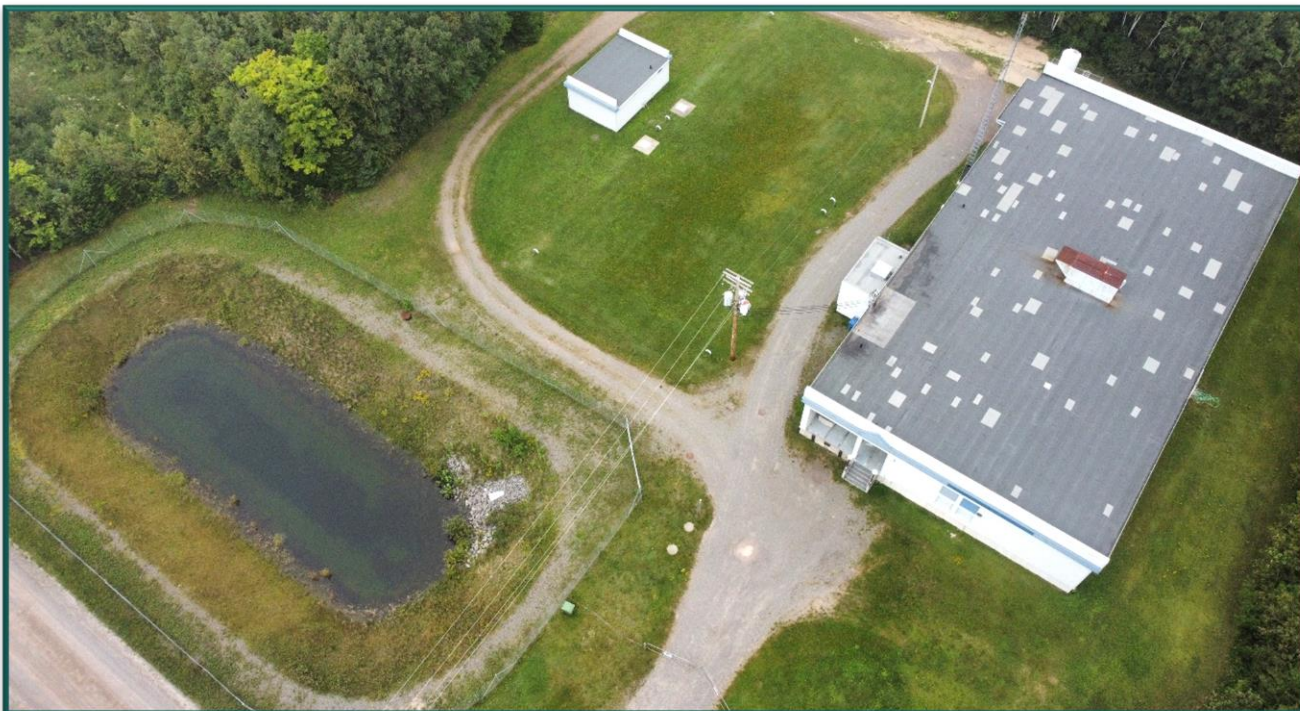
Figure 10 : Usine de filtration
